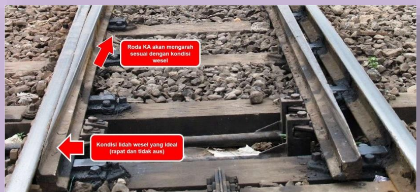
Gambar 3. Kondisi lidah wesel yang ideal (dapat mengarahkan roda KA dengan baik)
